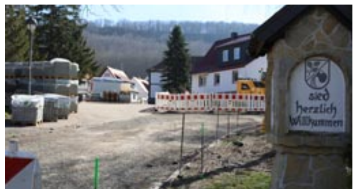
Die Straße "Rondelblick" im Ortsteil Vollenborn wird erneuert.
