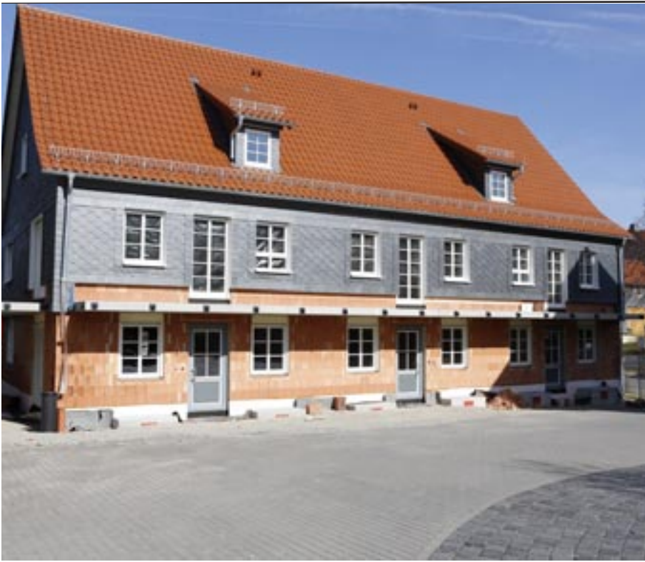
Das Mehrgenerationenhaus in Rüdigershagen ist eine der Baumaßnahmen
