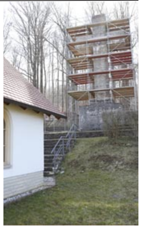
Das Dünkrenz wird ab 30.03.saniert.
