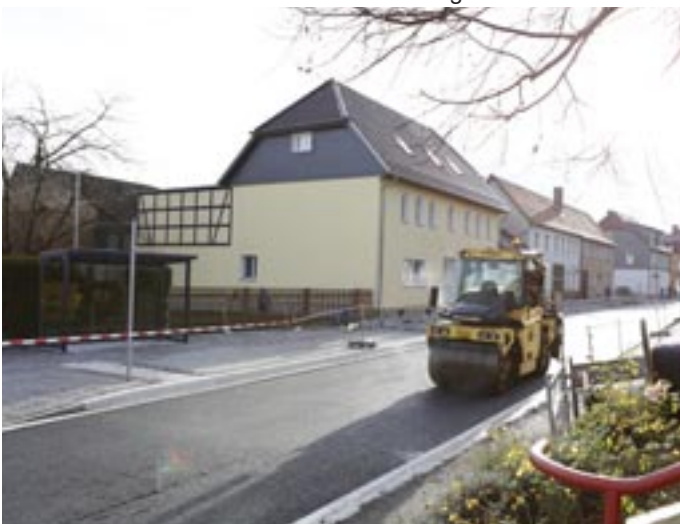
Der 1. Bauabschnitt Hauptstraße in Niederorschel wird im Mai fertiggestellt.
