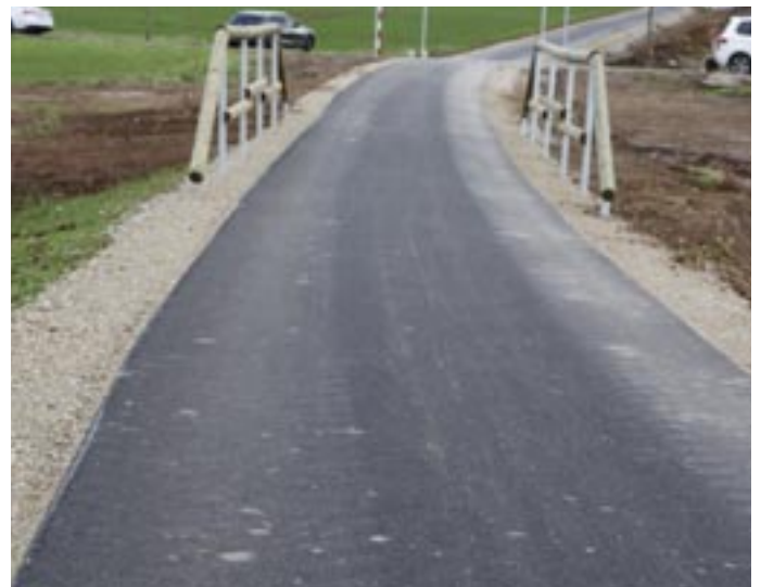
Der Radweg zwischen Reifenstein und Birkungen wurde bereits eingeweiht.
