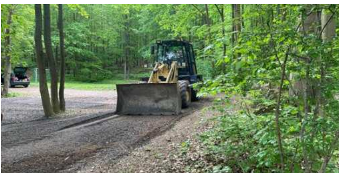
Bild: Ganz ohne Technik geht es nicht – Einsatz eines Radladers zur Erneuerung der Wege im „Waldstadion“
