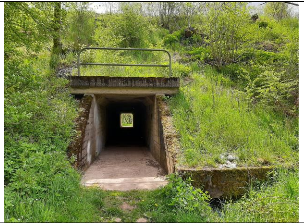
Bahnunterführung, Blickrichtung Osten
