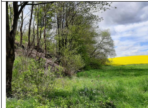
Böschung am Bahndamm, Blickrichtung Südwest
